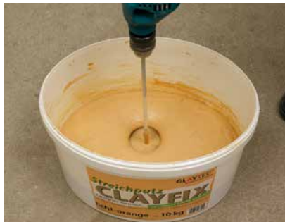
Nach 30 Minuten Quellzeit gut durchrühren
