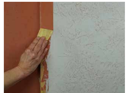
Abziehen scharfer Winkel
