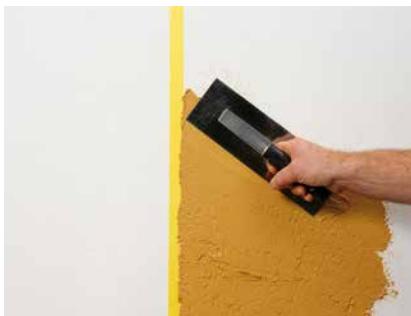
Auftrag der ersten Farbe an das Klebeband
