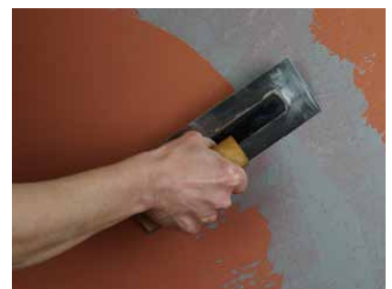
Auftrag der marmorierten Decklage
