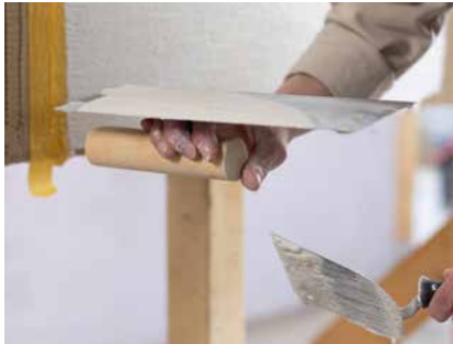
Entnehmen des Mörtels
