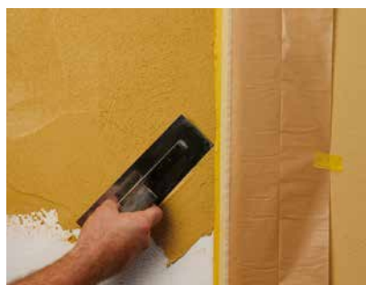
Auftrag des zweiten Farbtons
