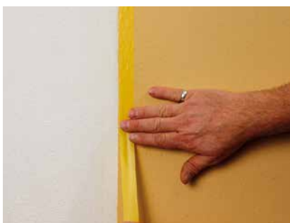
Erneutes Abkleben nach Trocknung
