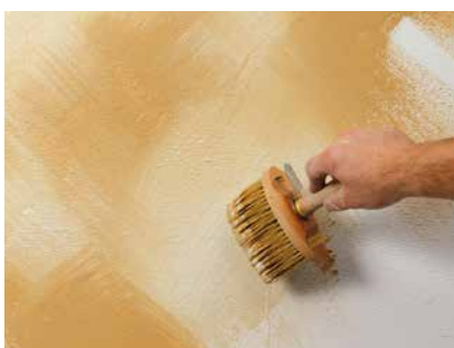
Auftrag der zweiten Farbe
