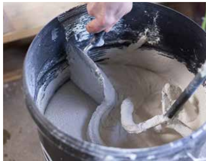
Nach 30 Minuten kräftig durcharbeiten, das Bild zeigt die verarbeitungsfertige Konsistenz
