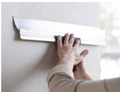
Abziehen mit dem Flächenspachtel
