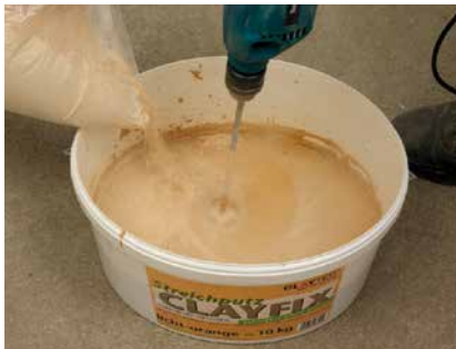
Einrühren des Eimerinhalts in Wasser
