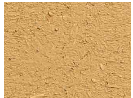
Struktur einer gut vorbereiteten Fläche aus Lehm-Unterputz
