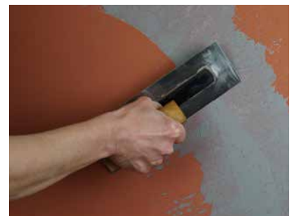
Auftrag der marmorierten Decklage
