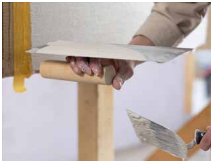
Entnehmen des Mörtels
