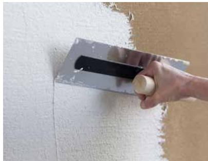
Aufziehen mit dem Glätter
