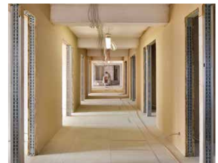
Lehm-Dünnlagen Beschichtung beim BV UN-Campus, Bonn
