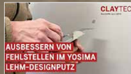
Ausbessern von Fehlstellen im YOSIMA Lehm- Designputz Anwendungsvideo 0:53 min.
