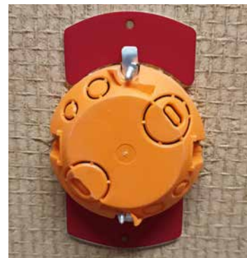
Hollewandoos gemonteerd, plaat achterzijde
