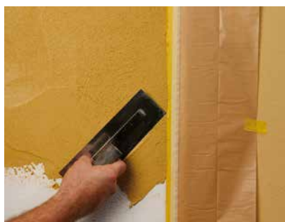
Auftrag der zweiten Farbtönen
