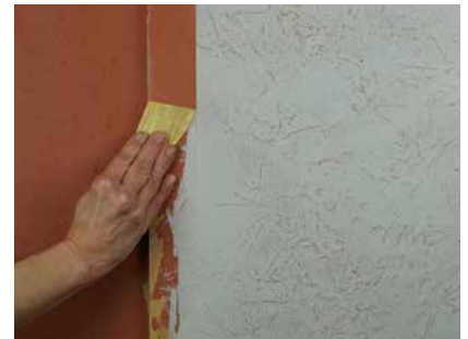
Abziehen scharfer Winkel
