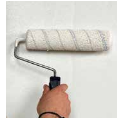
Lehmfarbe aufgetragen mit Rolle
