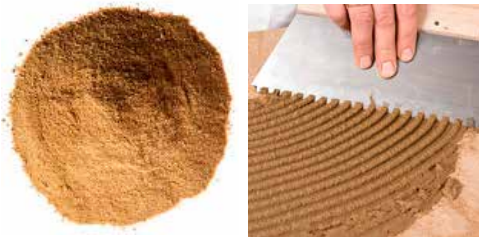
Lehmklebe- und Armiermörtel aufgetragen mit Zahnpachtel
